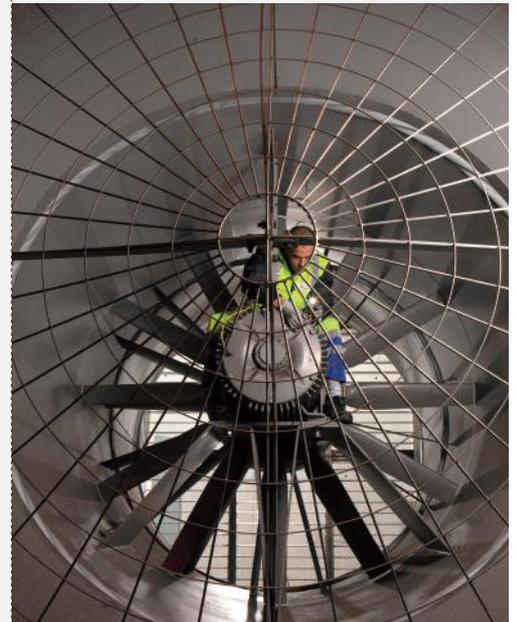
Des tests fonctionnels sont effectués périodiquement sur les 13 extracteurs de désenfumage du tunnel de Saint-Germain-en-Laye, sur l'A14.
