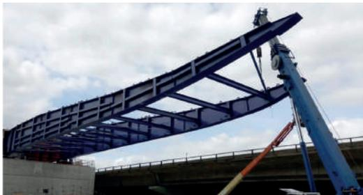
L'avant-bec permet de limiter les contraintes de lançage dans les poutres principales. Il est boulonné sur les extrémités des poutres principales du tronçon M1. Il reste en place pendant toute la phase de mise en place du tablier.
