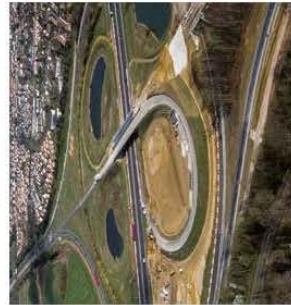
Exemple d'une création rétrograde d'un accès autoroutier sur l'A4.
