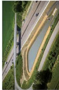
Exemple d'un bassin de traitement d'eaux sur autoroute, pour une bonne gestion environnementale.
