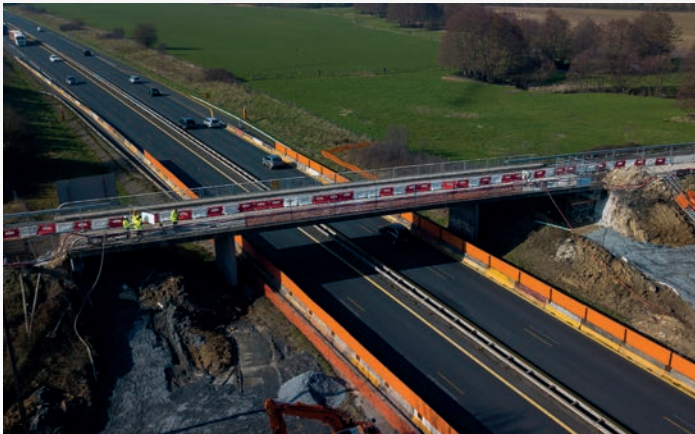
Ouvrage de la RD45C.
