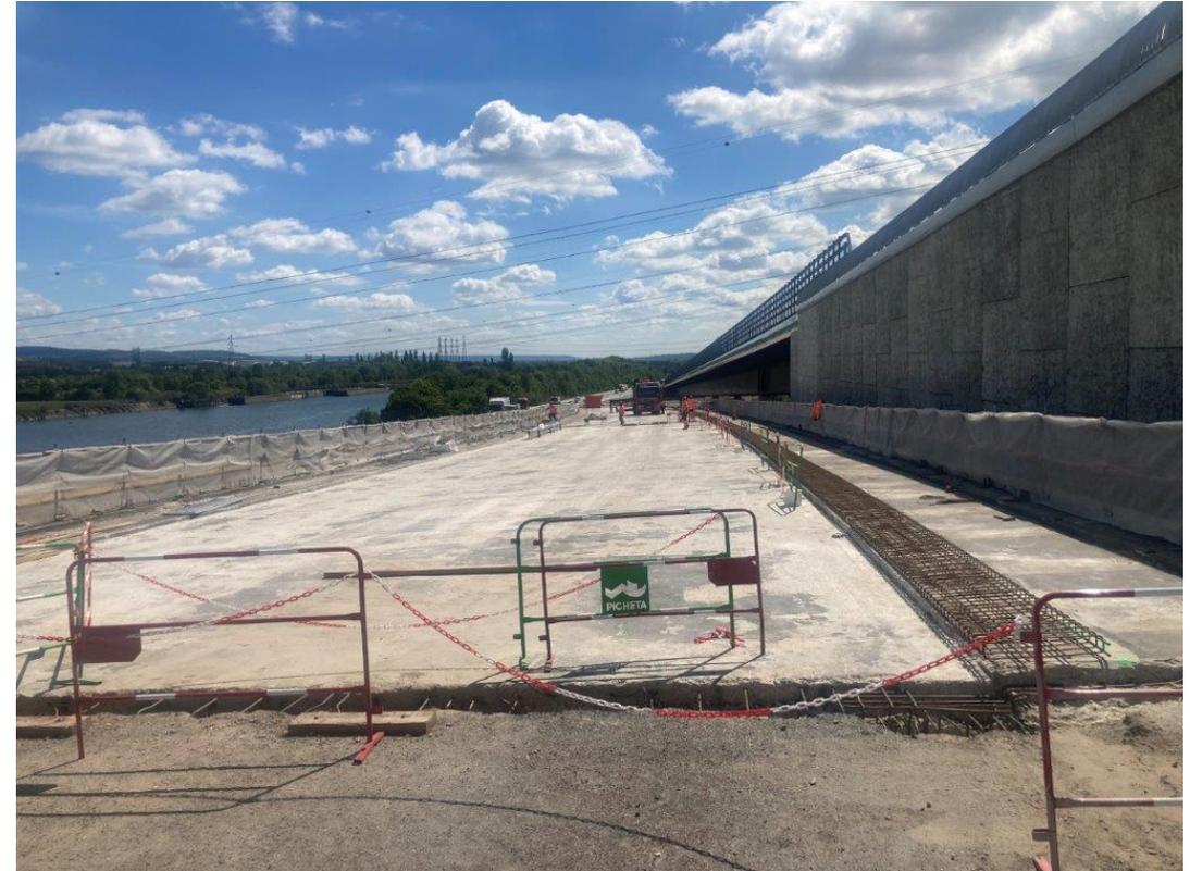
Décapage de l'enrobés et de l'étanchéité existante
