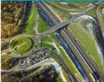
Le chantier au niveau du diffuseur et du parking de covoiturage d'Argancy
