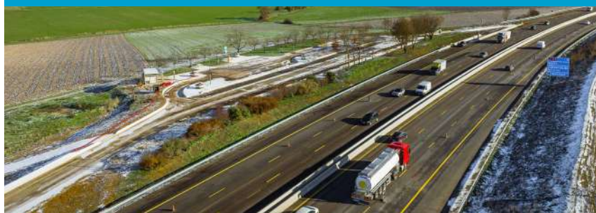
Vue de l'A4 à 3 voies en cours de finalisation
