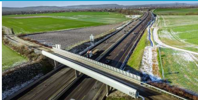
Pont supérieur (Bois de Fresnes) surplombant l'A4
