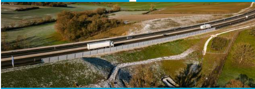
Mur acoustique sur la commune de Faily
