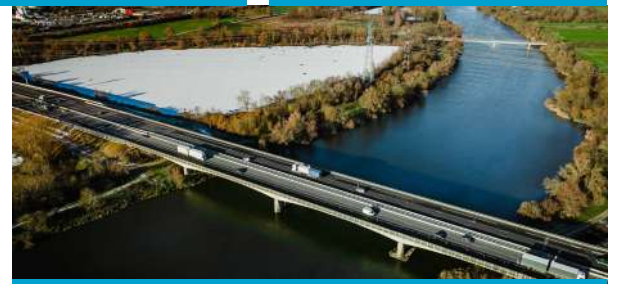
Vue du projet à partir du Viaduc de la Moselle – Argancy
