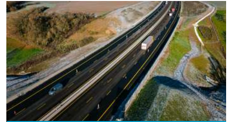
Nouvel enrobé posé entre l'échangeur A4/A31 et le diffuseur n° 35 d'Argancy
