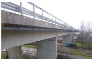
Du 15 juillet au 18 octobre\*, Sanef rénove les joints de chaussées de part et d'autre du Viaduc de Woippy. Ces équipements servent à assurer la continuité de la circulation entre la route et l'ouvrage lorsque le pont se dilate ou se rétracte en fonction des températures.
