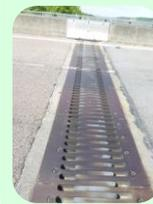
Ces éléments structurels servent à assurer la continuité de la circulation entre le pont et la route quand l'ouvrage se dilate ou se rétracte en fonction des températures extérieures.
